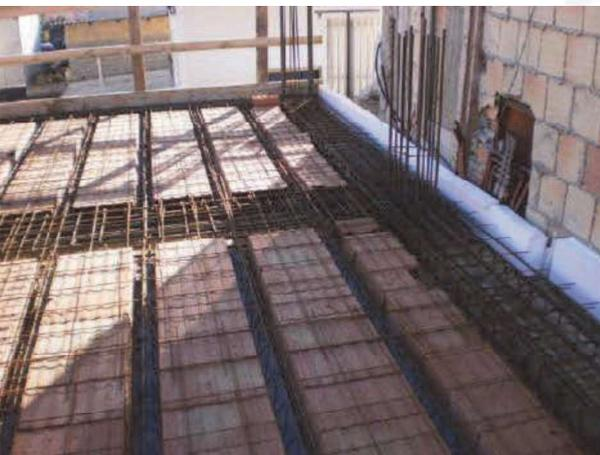
Armatura solaio in corrispondenza del giunto sismico
