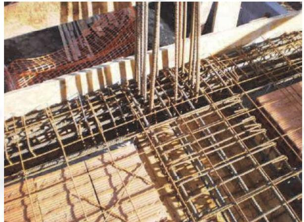
Armatura nodo trave - pilastro
