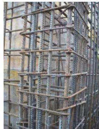
Armatura pilastro c.a.
